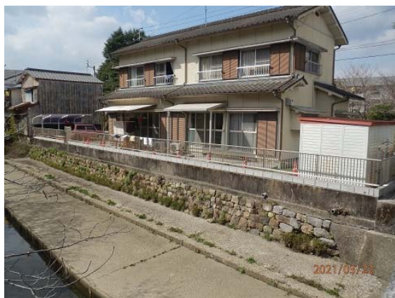
ブロック塀がフェンスになりました。
